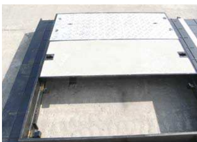
7 残った蓋を同様に開閉パールにて持ち上げる
