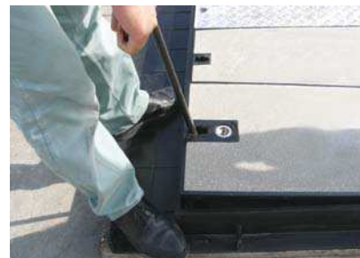
3 開閉パールで持ち上げる
