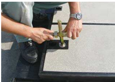
1 キャップを取り外しシリンダー錠を取る
