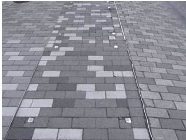
CAB設置状況
