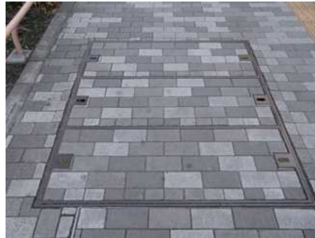
CCB蓋設置状況
